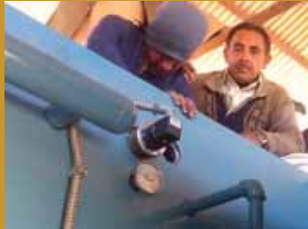
LPG team rectifies fault 05
